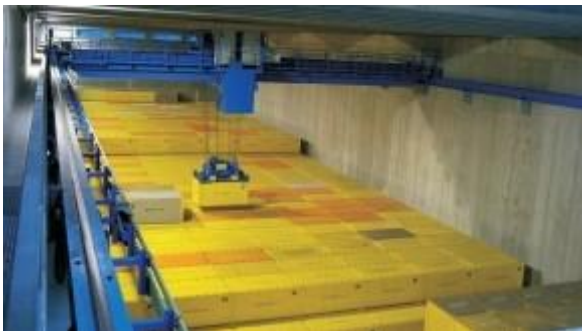
Lagerung von Abfallgebinden © WAK
